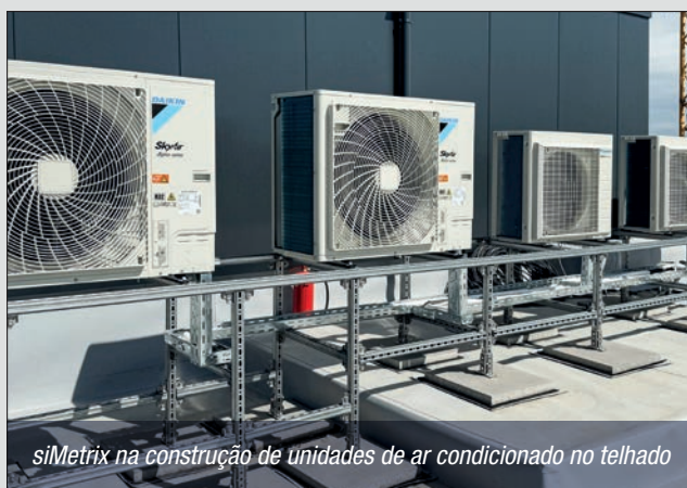
siMetrix ligado diretamente ao suporte de aço
