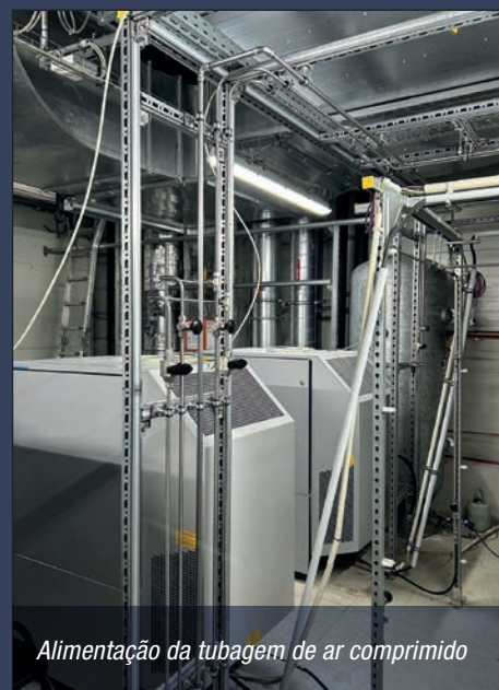
Grelha de fixação tridimensional para áreas com elevada densidade de instalação e requisitos exigentes de flexibilidade.
