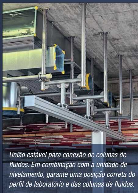
Grelha de fixação tridimensional para áreas com elevada densidade de instalação e requisitos exigentes de flexibilidade.
